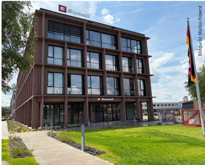
Das neue vierstöckige Bürogebäude am Firmensitz in Landau an der Isar
